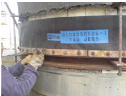
Fechamento de Junta de Expansão na Reduc
