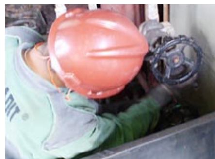
Engaxetamento de válvulas na Braskem - BA
