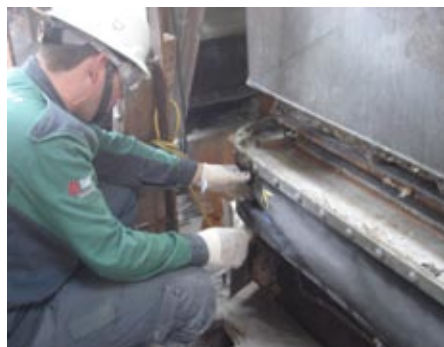
Na Braskem Unib-Sul instalação de Junta de Expansão
