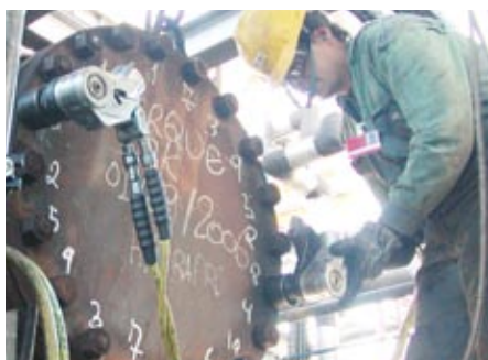
Aplicação de Torque Controlado na Replan
