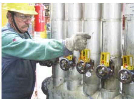
Engaxetamento de válvulas na Revap
