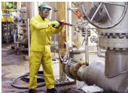
Posto de Juntas e Engaxetamento de válvulas na Braskem Unib-Sul
