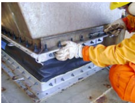
Instalação de Juntas FREEFLEX® na Plataforma P-35
