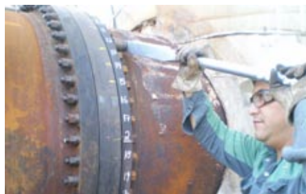
Deten: Vedação de Trocadores de Calor com torque controlado
