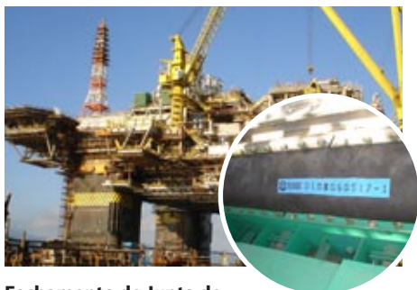
Fechamento de Junta de Expansão na P-51
