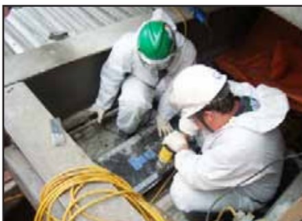
Fechamento de Juntas de Expansão na Braskem
