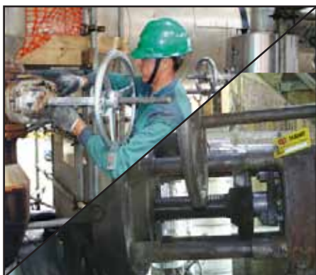
Engaxetamento de válvulas na REPAR, em Maio
