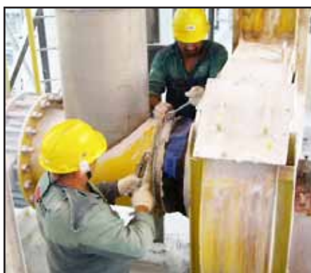
Instalação de Junta de Expansão, na Suzano
