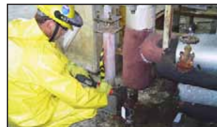
Desengaxetamento de válvulas na REGAP
