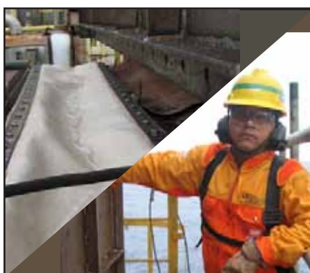
Fechamento de Junta de Expansão na P-37
