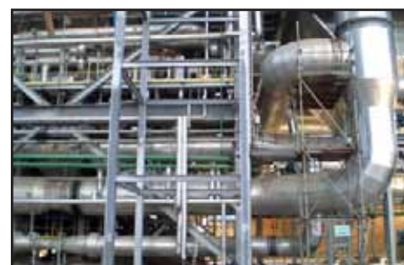
Instalação de juntas FREEFLEX® na Rigesa
