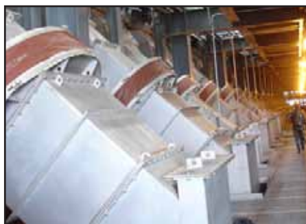
Juntas de expansão na Outotec-CSA
